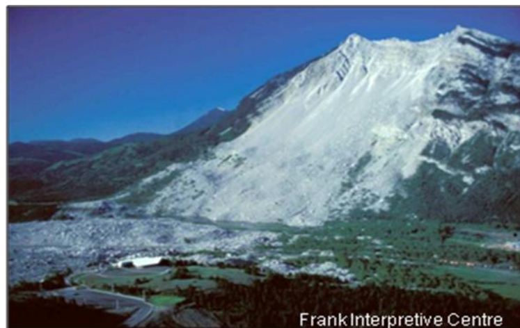
Figure 1. 23 : Glissement de Frank, Alberta 1903 du Canada
