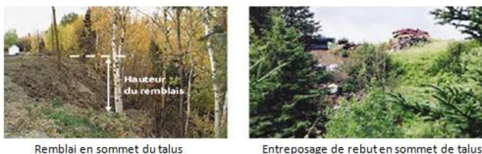
Figure 1. 18 : Surcharge au sommet de talus.
