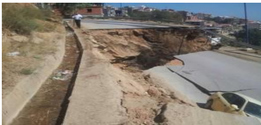
Figure 1. 27 : Glissement terrain à El Biar(Alger), en février 20
