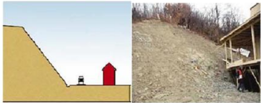
Déblai à la base du talus
