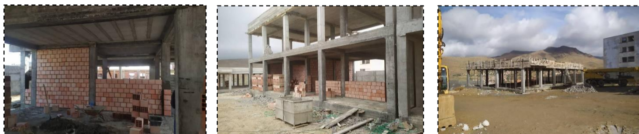
Figure 55 : Les photos de chantier L'avancement des travaux février 2026, Source : l'étudiant
