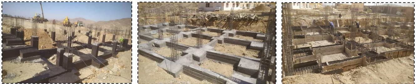
Figure 50 : Les photos de chantier les travaux de fondation, Source : BET
