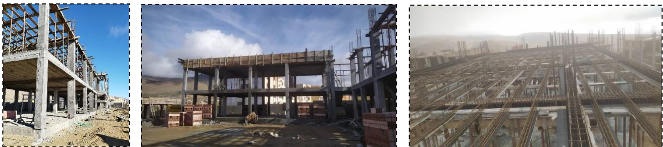
Figure 53 : Les photos de chantier L'avancement des travaux décembre 2025, Source : l'étudiant
