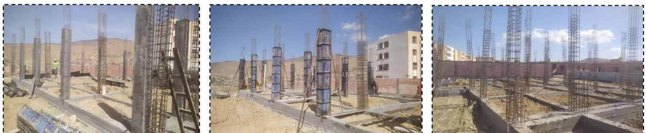
Figure 51 : Les photos de chantier L'avancement des travaux octobre 2025, Source : BET
