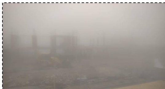
Figure 54 : La photo de chantier arrêt total des travaux janvier 2026, Source : l'étudiant
