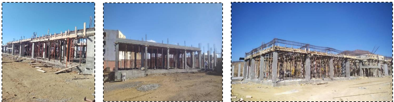
Figure 52 : Les photos de chantier L'avancement des travaux novembre 2025, Source : l'étudiant
