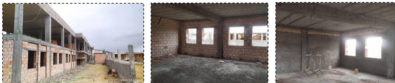
Figure 56 : Les photos de chantier L'avancement des travaux mars 2026, Source : l'étudiant
