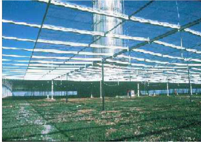
Figure 2 : Verrière du collecteur d'une cheminée solaire[11]
