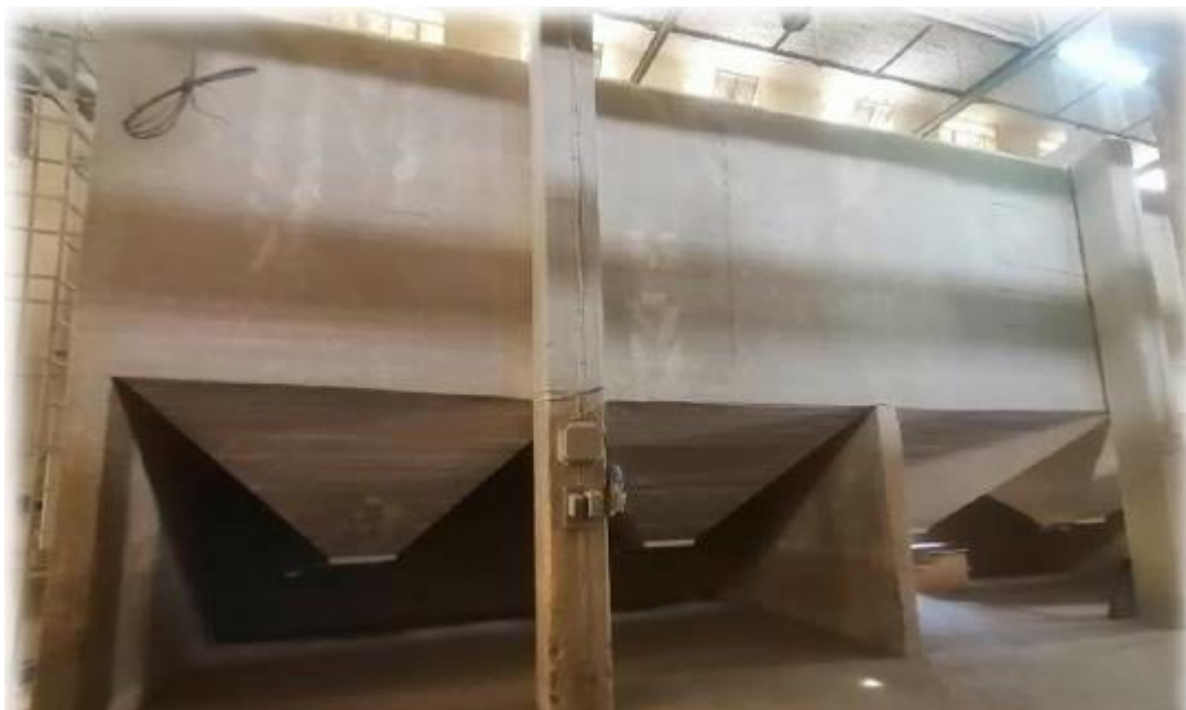
Figure 05 : Un groupe de silos est en béton (Belyagoubi, 2006).
