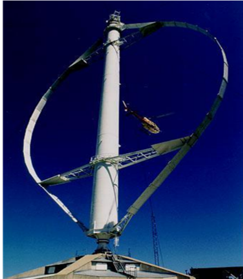
Fig. IV.2.a : Éolienne à axe verticale type Darrieus
