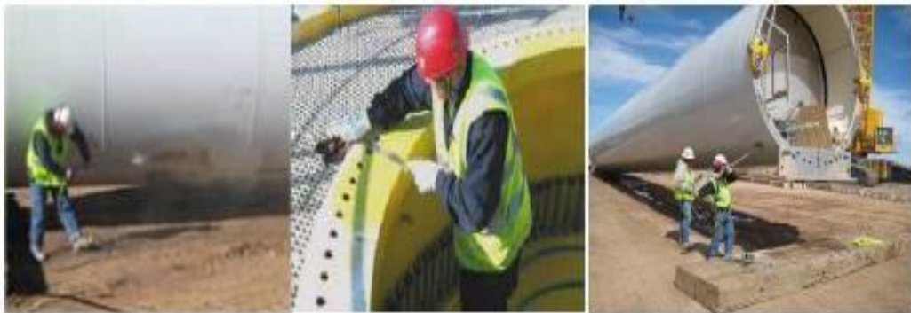
Fig. II.6. Préparation de la tour
