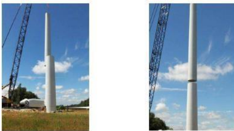
Fig. II.7 L'ensuite d'assemblage de la tour
