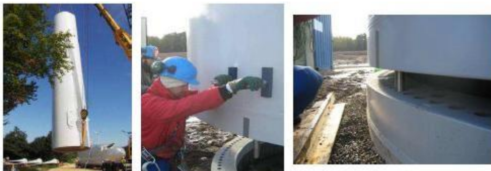
Fig. II.6. Assemblage de la tour
