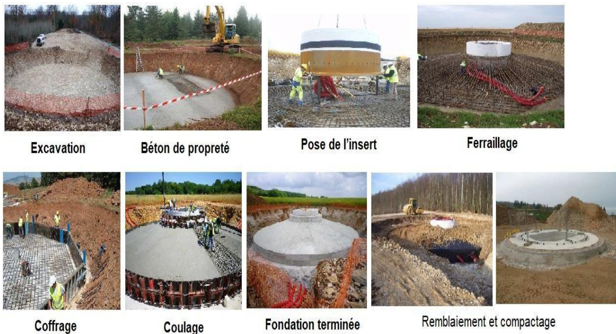
Fig. II.5. Les étapes de fondation sur le sol
