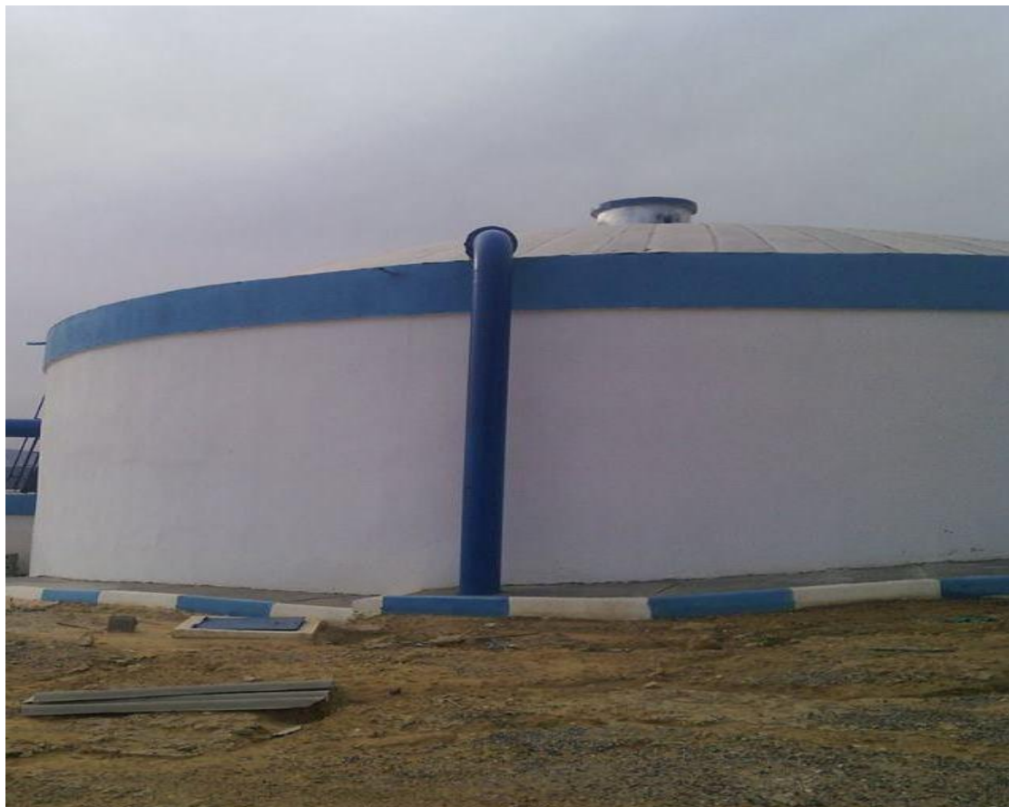
Figure (I.1) : Réservoir de stockage de type semi-enterré (de la commune de Medjedel)
