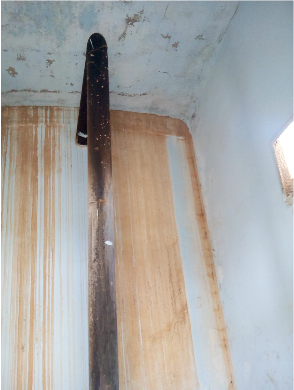
Figure (I.3.3) : Conduite d'adduction (d'arrivée) photo réel de réservoir de notre étude
