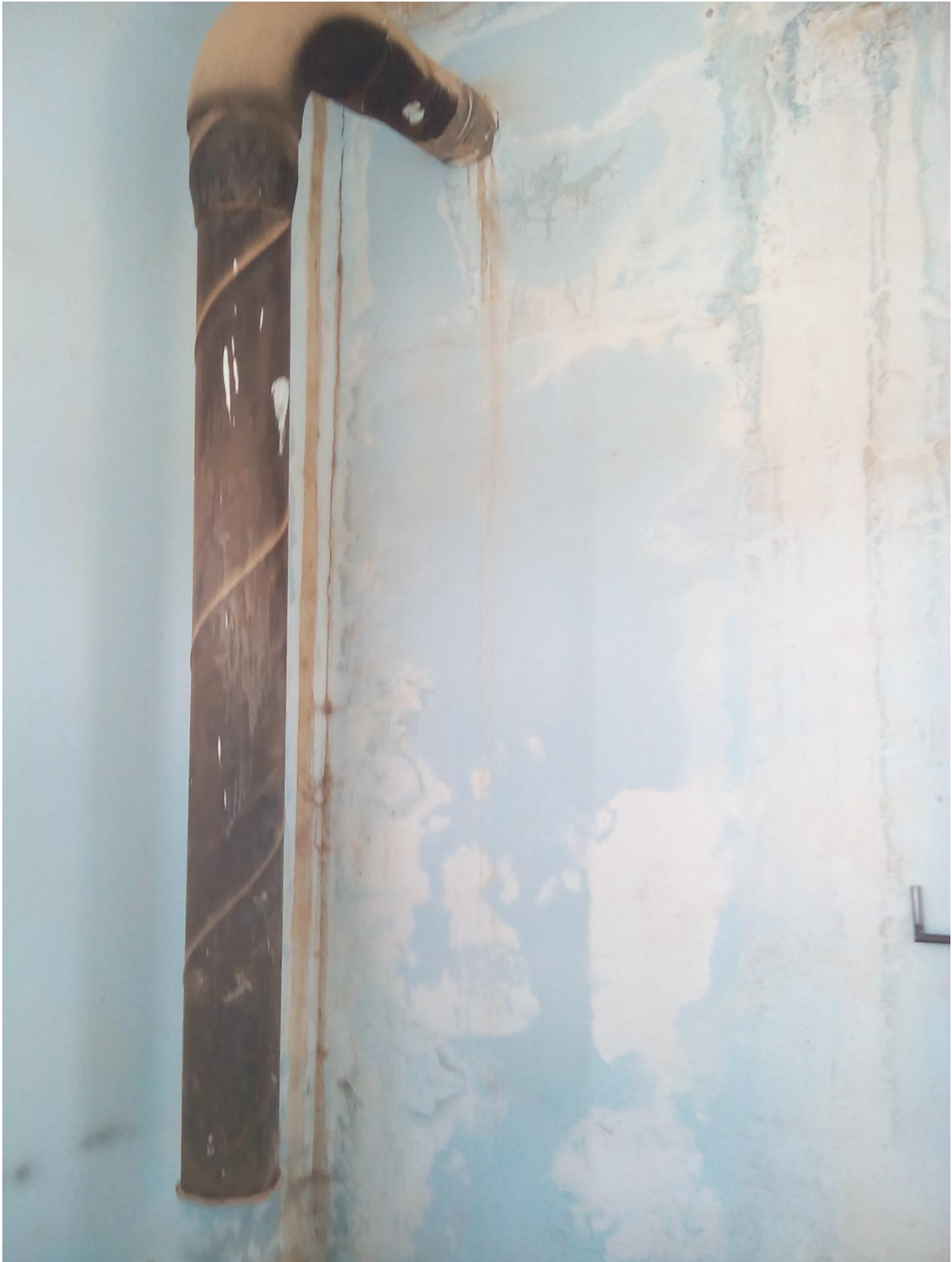
Figure (I.5.1): Conduite de trop pleine photo réelle de réservoir de notre étude
