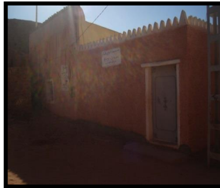
الصورة رقم 13: مسجد
