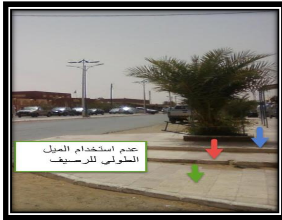
الصورة رقم(28):عدم استخدام الميل الطولي للطريق
