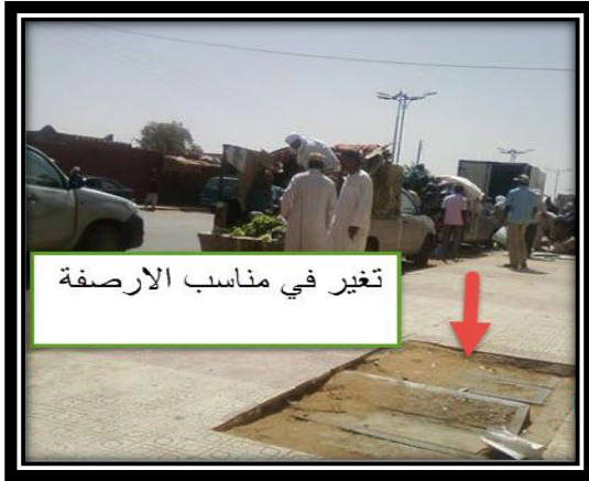
الصورة رقم(28):عدم استخدام الميل الطولي للطريق
