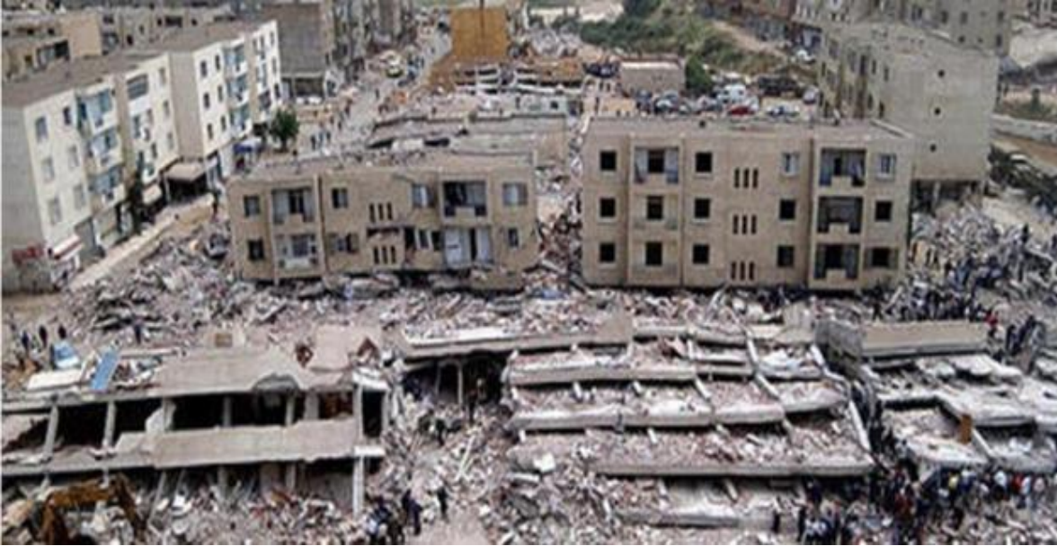
صور رقم (18): سقوط البنايات وغلق ممرات وطرق النجدة والاسعاف
