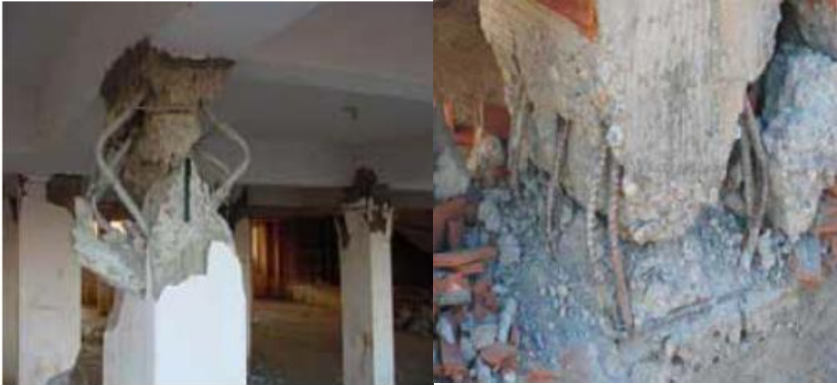
صورة رقم (20): نقص حديد التسليح وعدم احترام مسافة تموضع كانت التسليح
