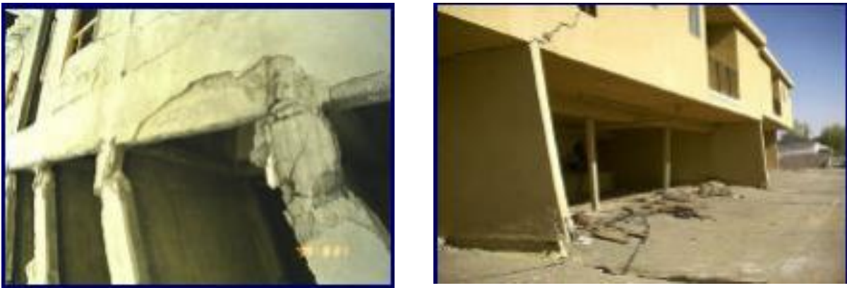
Figure I.16: Dommages dus à l'absence de contreventement longitudinal, séismes de San Fernando, Californie 1971 et d'Izmit, Turquie 1999. [3]
