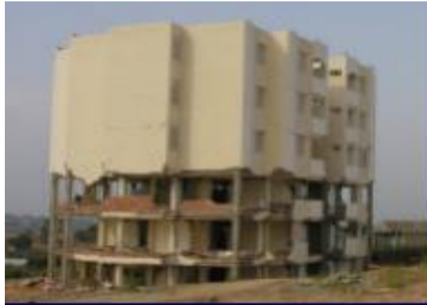
Figure I.18: Immeuble (R+4) ,140 logements à Dellys (Séisme de Boumerdes 2003), Algérie. [3]
