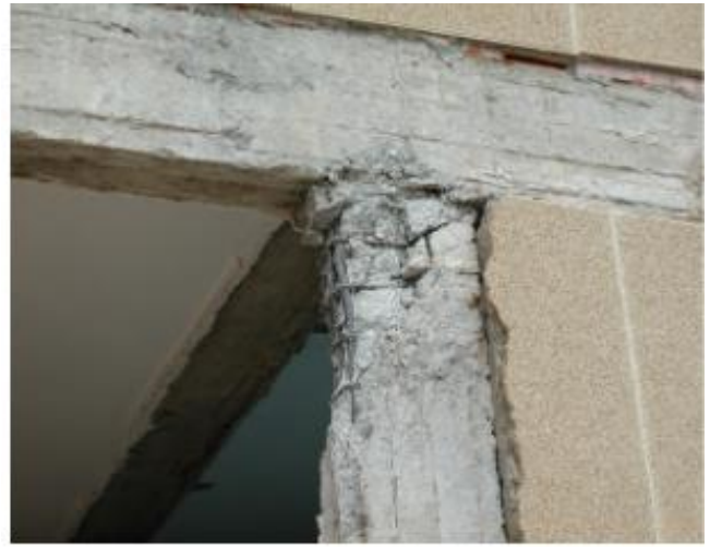
Figure I.13: Rotule dans le poteau (Comportement à éviter). [10]
