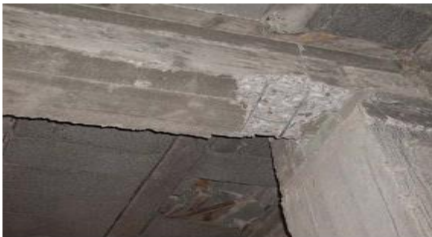
Figure I.14: Rotule dans la poutre (Comportement recherché). [10]
