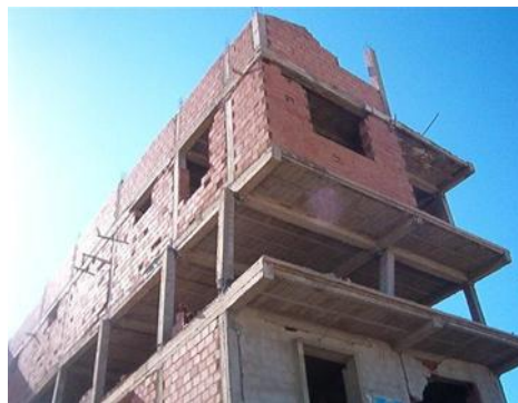
Figure I. 3: Cisaillement des poteaux d'une construction à Bordj el bahri .
