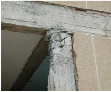
Figure I. 1: Rotule dans le poteau (Comportement éviter) [4]
