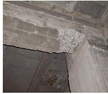
Figure I. 2: Rotule dans la poutre (Comportement recherché) [4]
