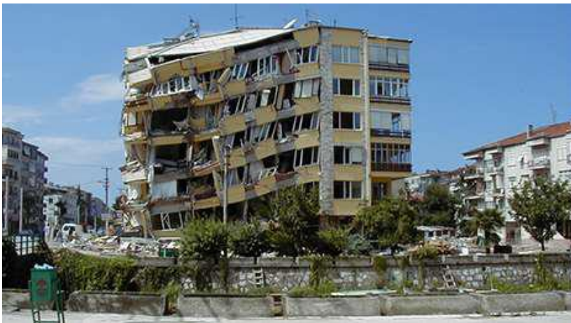
Figure I.14 : Destruction des bâtiments par torsion du béton armé, Séisme de Gölcük, 17 août 1999 (Turquie) [10].
