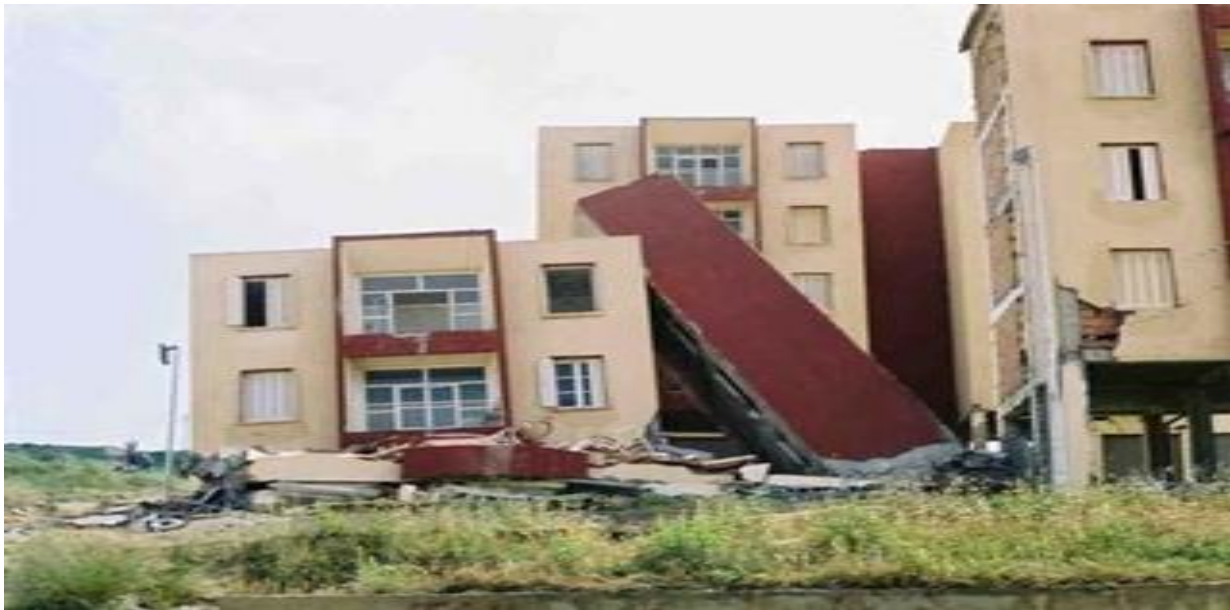
Figure I.18 : Immeuble (R+4) ,140 logements à Dellys (Séisme de Boumerdes 2003), Algérie [3].
