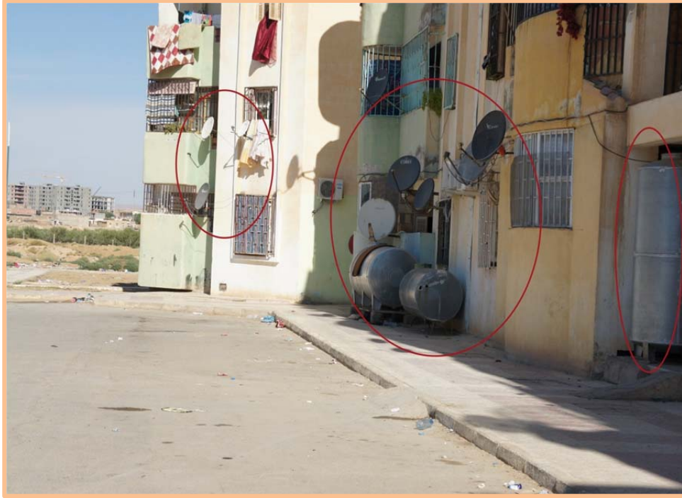
صورة رقم(19): تمثل ظاهرة تموضع خزانات الماء والهوائيات المقعرة في حي 400 مسكن
