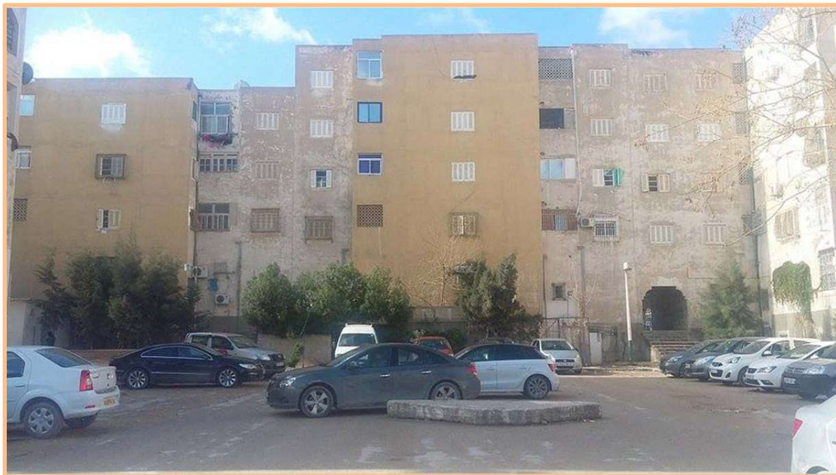
الصورة رقم(04): تمثل واجهة عمارة بحي سكني بمدينة تبسة
