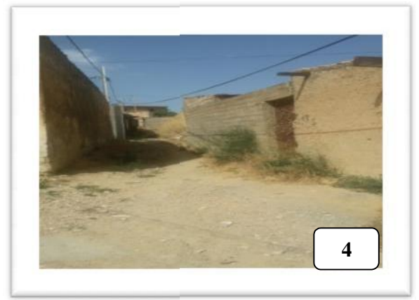
Impasses mauvais état
