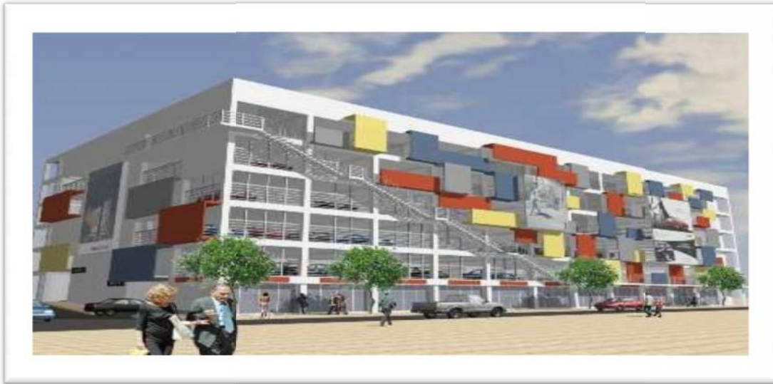
Fig- I- 17: Vue d'ensembles du parking (Rouïba)
