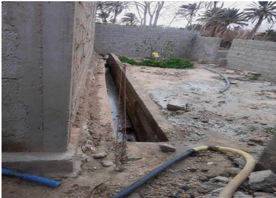
Image 18 : Des nouvelles constructions d'habitat anarchique en cours de réalisation
