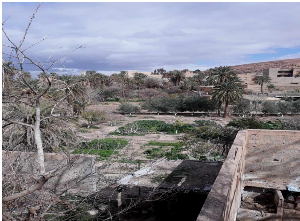
Image 19: Construction anarchique dans la palmeraie de Boussaâda
