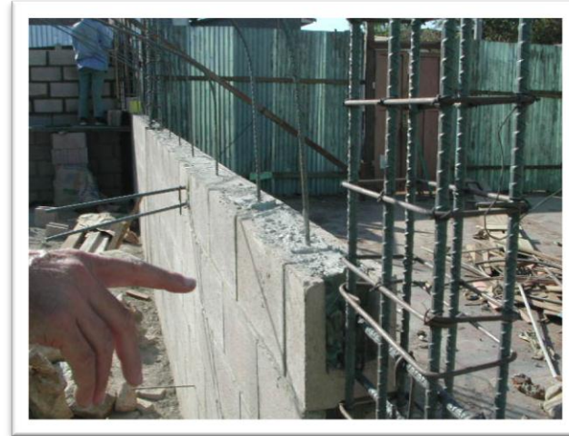
Figure 3.9 -Maçonnerie armée de remplissage avec joint résilient périphérique [24] .
