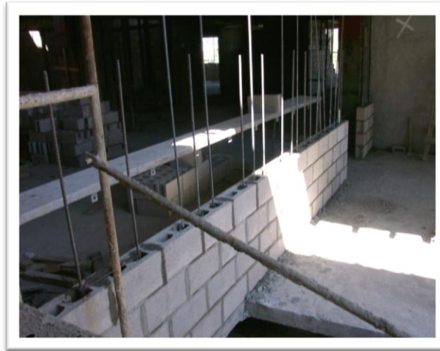
Figure 3.9 -Maçonnerie armée de remplissage avec joint résilient périphérique [24] .
