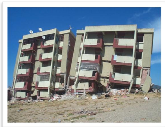
Figures( 3.14 , 3.15) : Insuffisance de la largeur du joint entre les blocs de bâtiments ( joint de dilatation traditionnel de 2 cm)
