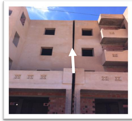
Figure 3.17 : Joint parasismique vertical entre deux bâtiments.
