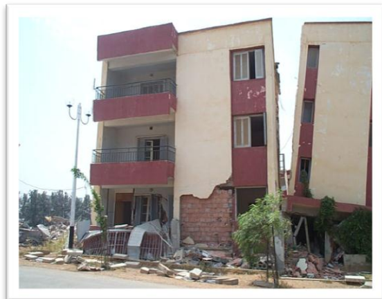
Figures( 3.14 , 3.15) : Insuffisance de la largeur du joint entre les blocs de bâtiments ( joint de dilatation traditionnel de 2 cm)
