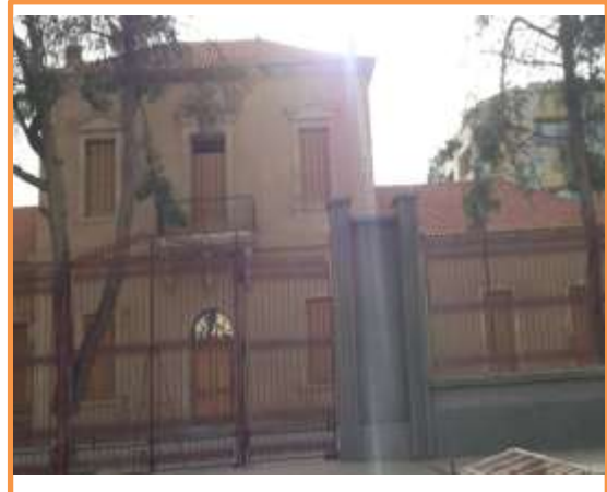
الصورة رقم(50): ملحقة البلدية في المنطقة 5
