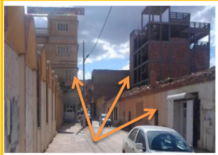
الصورة رقم(102) تباين أشكال وارتفاع بنايات
