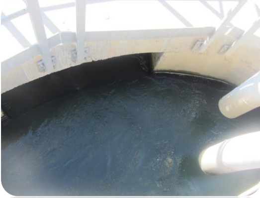
الصورة رقم (39): مركز تصفية المياه
