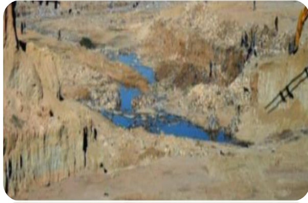
الصورة رقم (38): مصب تصريف المياه المستعملة
