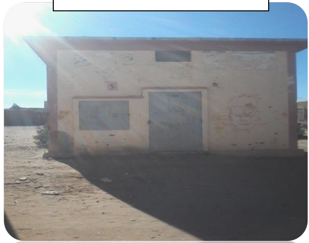
الصورة رقم (58): محول كهرباء
