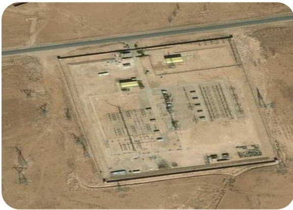
الصورة رقم (41): صورة جوية لوحدة توزيع الكهرباء بالمدينة
