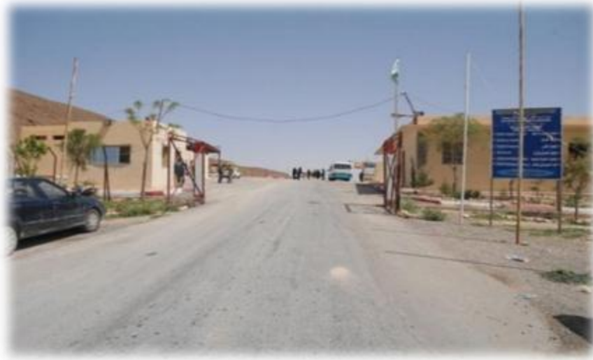
الصورة رقم 28: توضح مدخل مركز الردم التقني.
