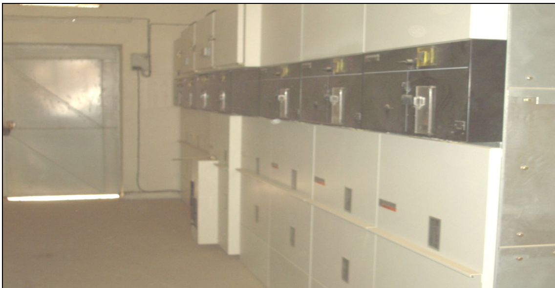
Figure (III.6) Représentation des cellules du poste de la briquetterie.
