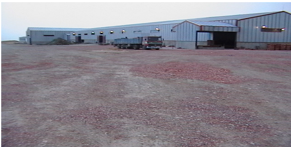
Figure (I.3) Briqueterie d'EL KALAA/HAMMAD
