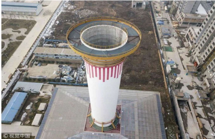
Figure I.6 : Exemple de cheminée (La tour) [7].
