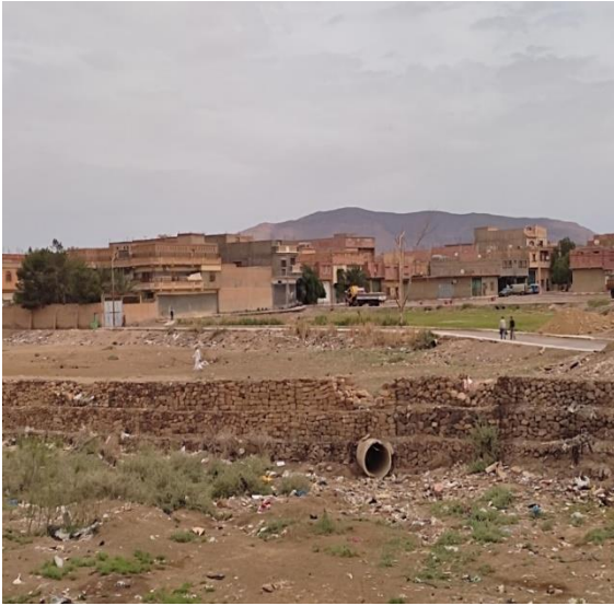
A l'entrée de l'oued ,il existe une conduite d'assainissement qui est du à la station d'épuration
