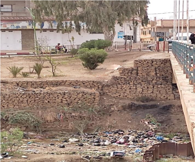
Dans les années 1980 ,un gabion a été construit tout lr longe de l'oued
