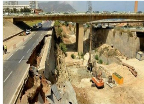
Figure 1.12 : Rupture rotationnel avec fissuration
