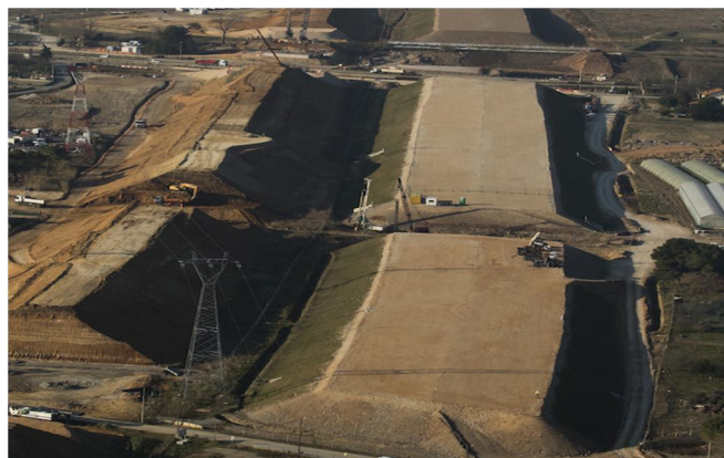
Figure 1.3 : Remblai de grande hauteur
