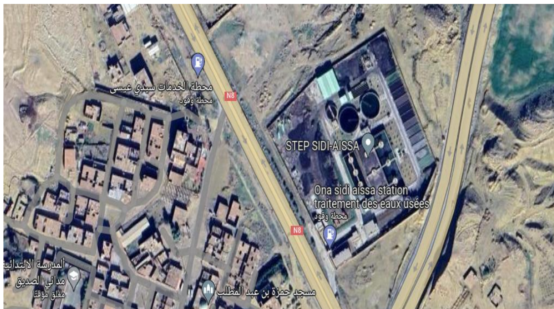
Figure 15 : Vu de la STEP de Sidi Aissa (Google earth, 2023).
