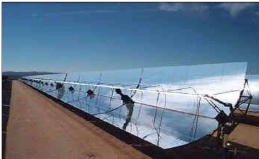
Fig.2.9. Concentrateur cylindro-parabolique [9]
