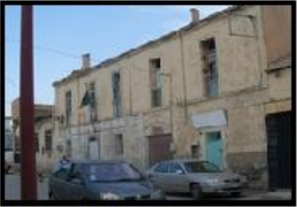
Source : Etudinats Fig 82 : Construction en moyen état
