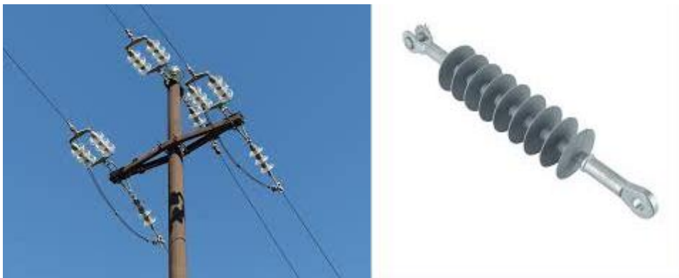
Figure I.4: Isolateurs de lignes aériennes
