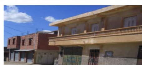
صور رقم (08): توضيح عدم اكتمال الواجهات وغياب التناسق والانسجام
