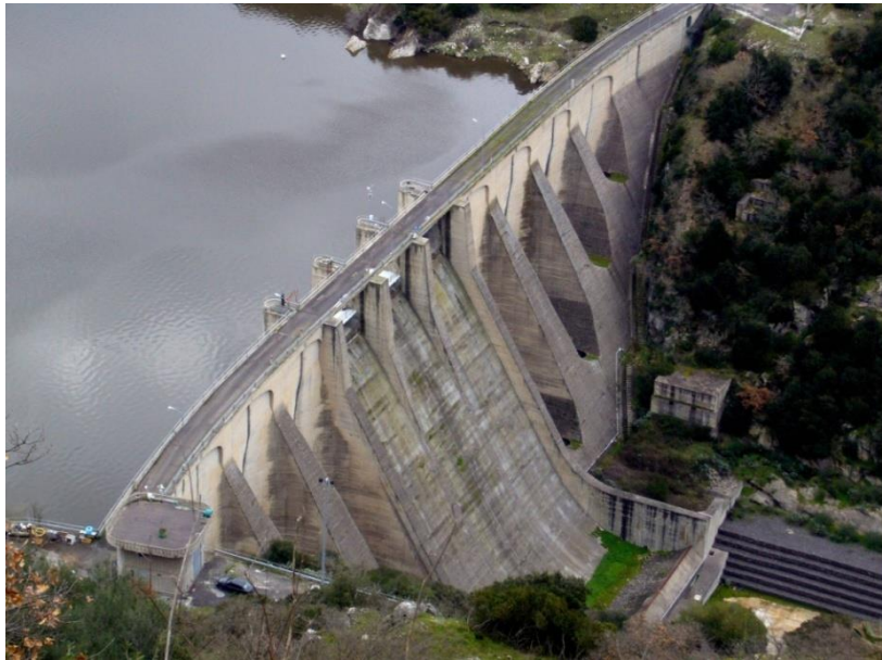
Figure1. 2:Un barrage-poids évidé : le barrage amont d'Aussois en Savoie
