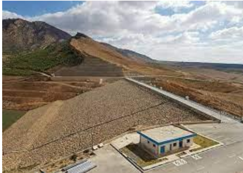
Figure1. 9: Barrage en enrochement barrage (Soubela-M'sila)
