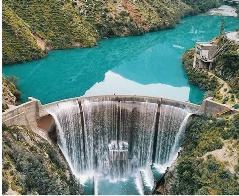
Figure 1. 3: barrage voûte ( Darguina-Bédjaia)
