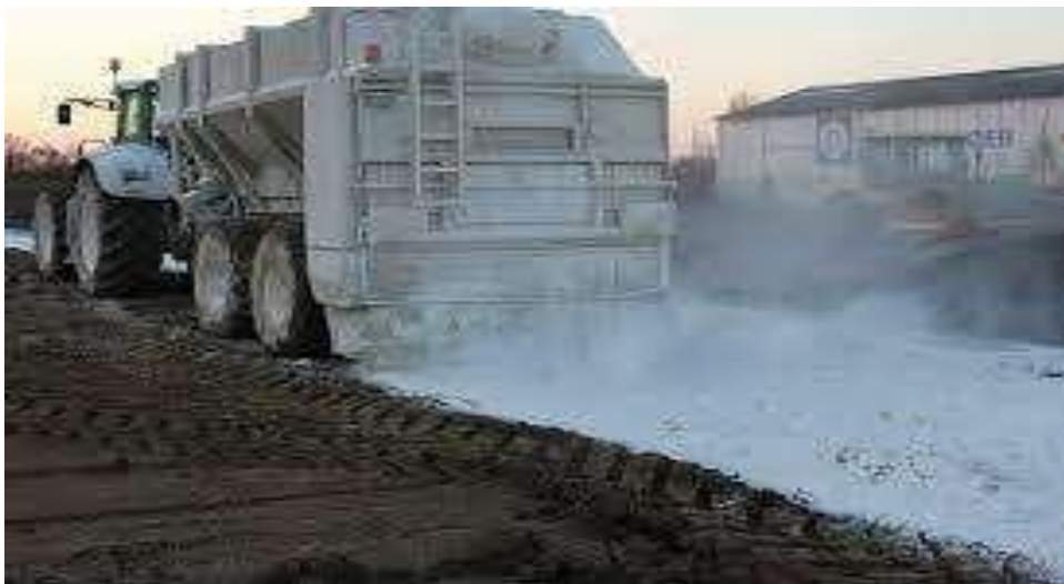
Fig. 1.3 Traitement à la chaux
