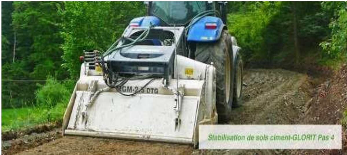
Fig. 1.4. Traitement par ciment
