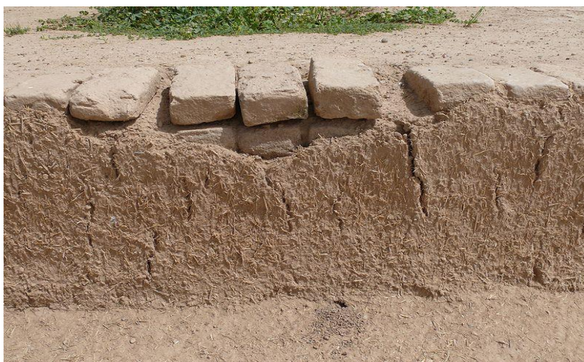
Fig2 :Reconstitution archéologique d'un mur. Briques de terre crue et mortier de terre fibré. Apadana de Suse . Iran.
