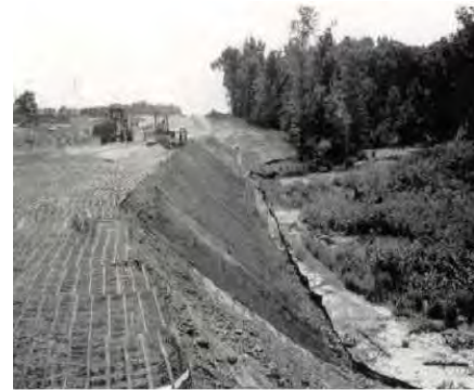
Renforcement de pente [6].
