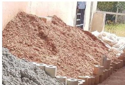
Figure II-1 Sol argileu-sableu BOUKHMISSA M'sila
