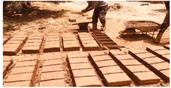
Figure I-30: Moulage et séchage des blocs adobes (Hanane, 2018)
