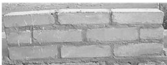
Figure I-38 Mur Après 48 mois d'exposition avec 5% stabilisant (ciment) (Guettala, Abibsi, & Houari, 2006)
