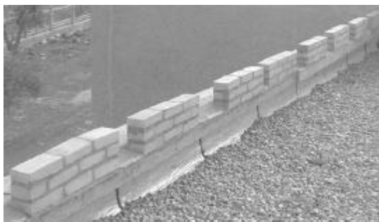
Figure I-39 Vue générale des murs en briques de terre (Guettala, Abibsi, & Houari, 2006)
