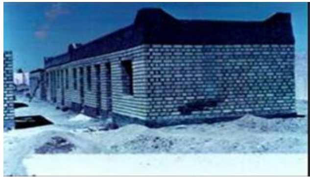
Figure I-19logements en B.T.C à Tamanrasset (Le CNERIB
