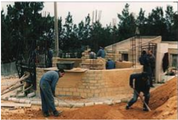
Figure I-20premières assises du prototype de (S.Safia, 2014)
