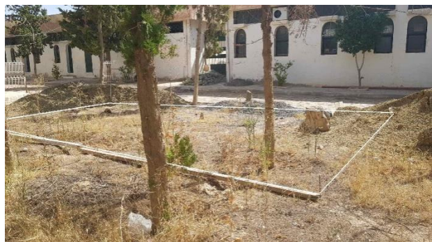
Figure III-31 Choix du terrain et Piquetage en face du LDGM université M'sila
