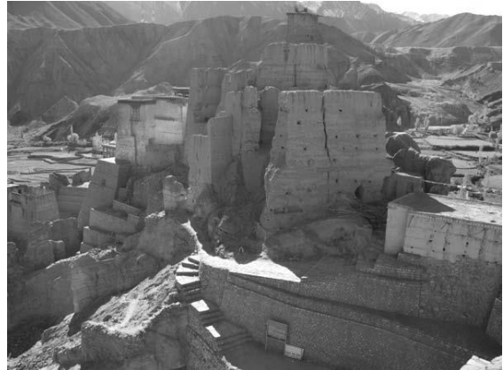
Figure I-26 Section de pisé du monastère de KyichuLhakhang, Bhouta
