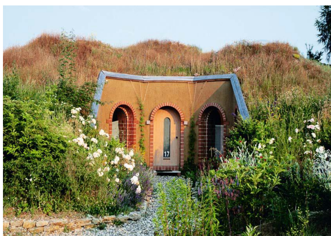
Figure I-5 Résidence cum office, Kassel, Allemagne
