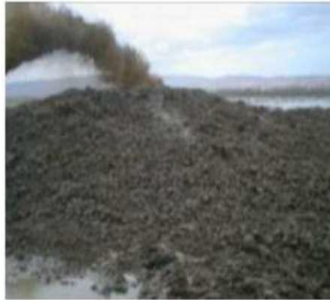
Figure 1.15. Rejet de la vase draguée (Barrage de Fergoug)
