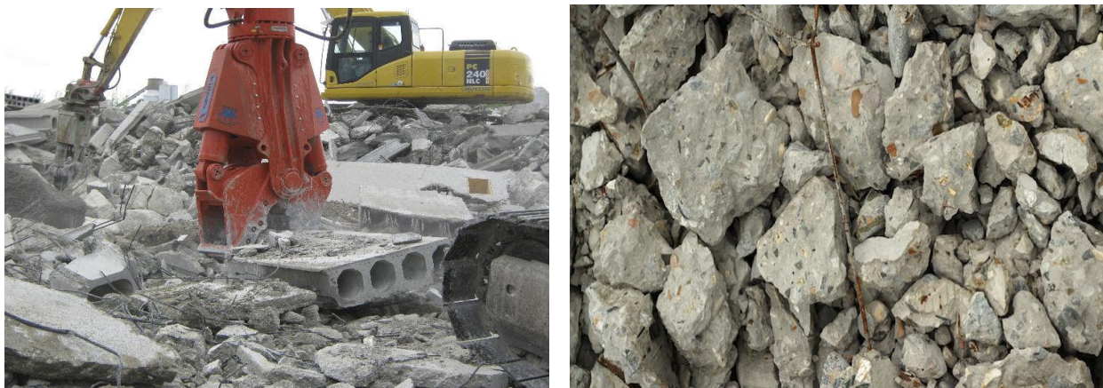
Figure II-2 : déchets de béton provenant de démolition des structures
