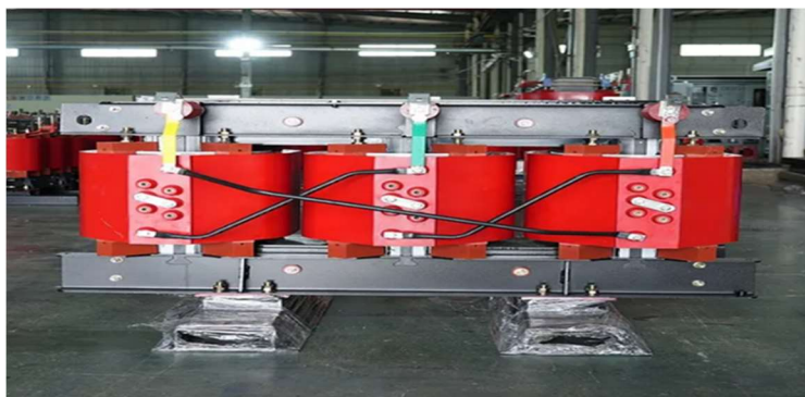
Figure (II.1) : transformateur couplage triangle étoile
