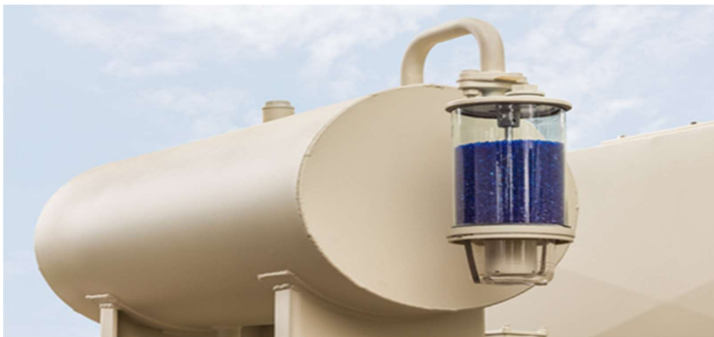
Figure (I.10) : conservateur d'huile de transformateur
