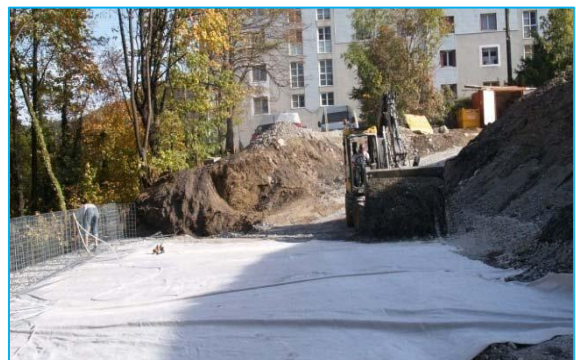
Figure I. 37 A gauche structure d'un géotextile, à droite une nappe de géotextile
