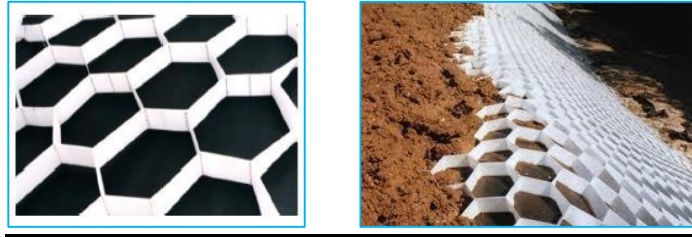
Figure I. 42 Forme d'un géosynthétiques alvéolaires, à droite placement d'une nappe
