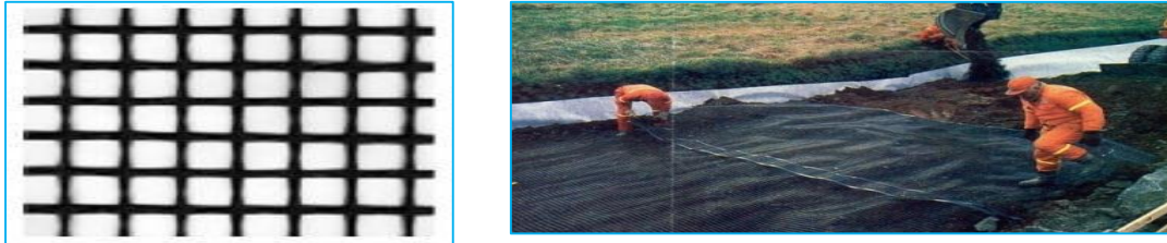
Figure I. 38 Géogrille, et sa mise en place
