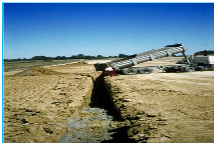
Figure II. 10 Drain vertical recreusé dans le remblai et remplissage par du sable
