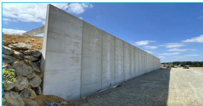
Figure I. 32 Murs de soutènement
