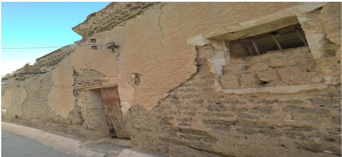
Photo.2.12: Une extrémité de la médina de Boussaâda. On observera que l'architecture traditionnelle de ksar utilise largement le (Toub) (Photo : SAADAoui Benaceur OUAHAB Yamina)
