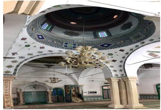
Photo.2.9: Plafond de la mosquée de la zaouïa. On devine la hauteur du dôme central de la mosquée. (Youssef N, 2013).
