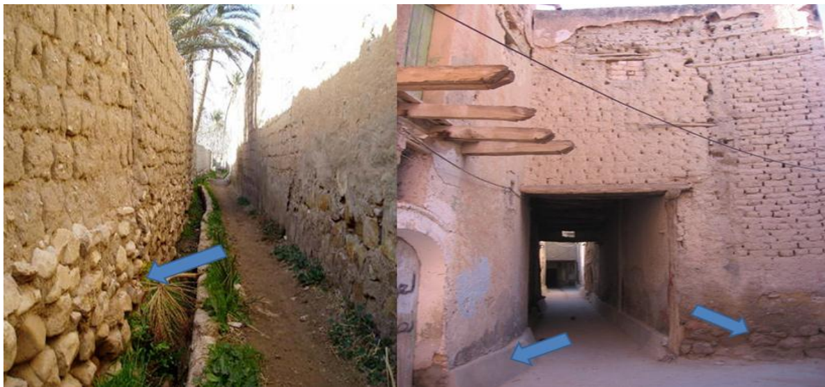
Photo.2.13 : La photo de gauche est un mur séparant les vergers et à droite un immeuble résidentiel et impasse recouverte ouvrant sur une ruelle (Photo : SAADAOUI Benaceur OUAHAB Yamina)
