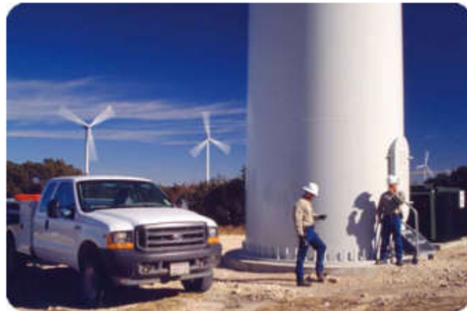
Figure I.9 : Tour d'une turbine.
