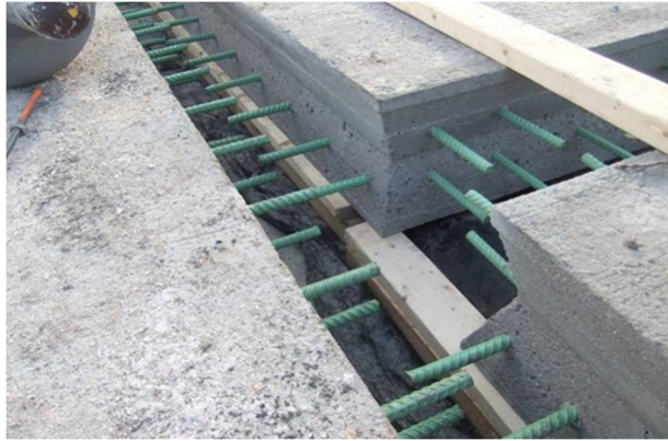
Figure : tablier de pont préfabriqué
