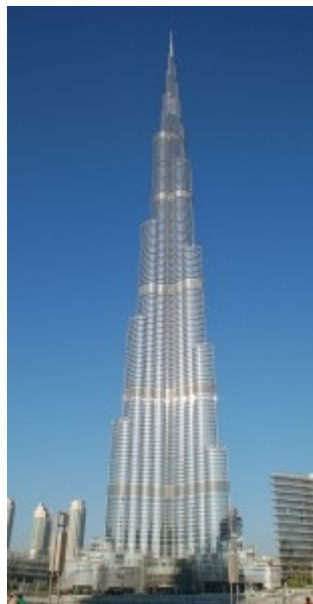
Fig.II.5. Bordj Khalifa réalisé par un béton à fumée de silice.
