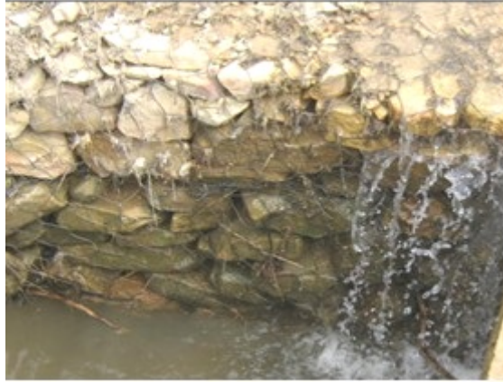
Fig.I.14.Seuil de sédimentation en gabions et en pierres sèches.
