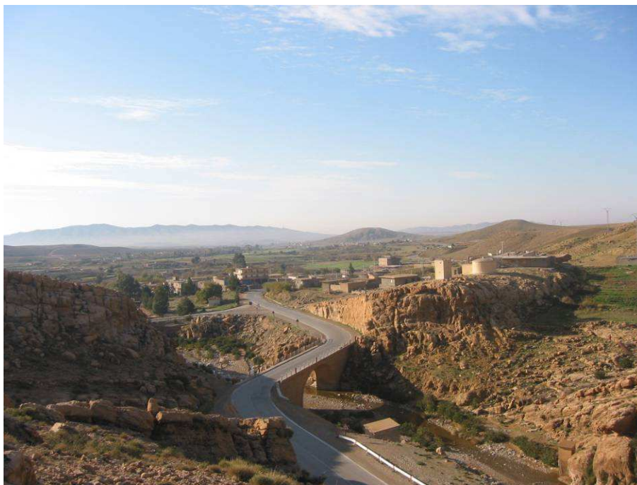
Photo N°6 : Vue de l'aval depuis l'axe du barrage
