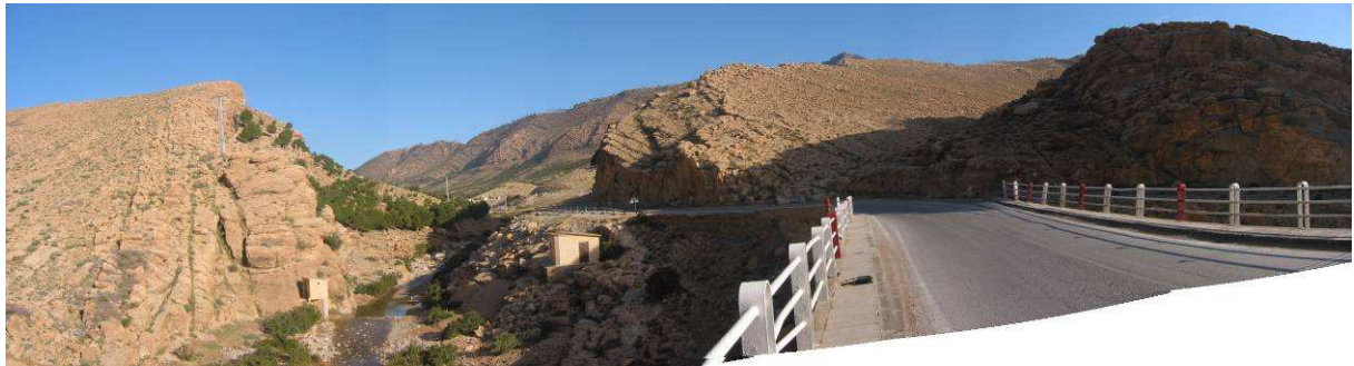
Photo N°1 : Vue de l'axe du barrage à partir de l'aval
