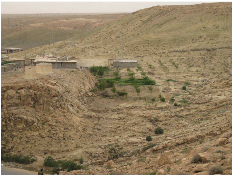
Photo N°7 : Détail de la partie droite de la photo 6 montrant la faille inverse.
