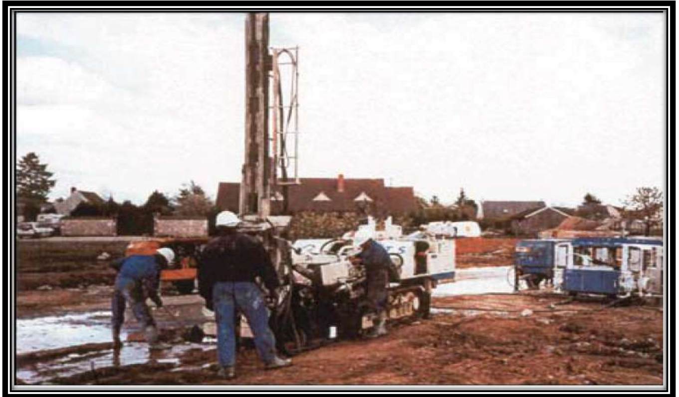
Figure I- 13: image représentant un atelier de forage et pompes d'injection.
