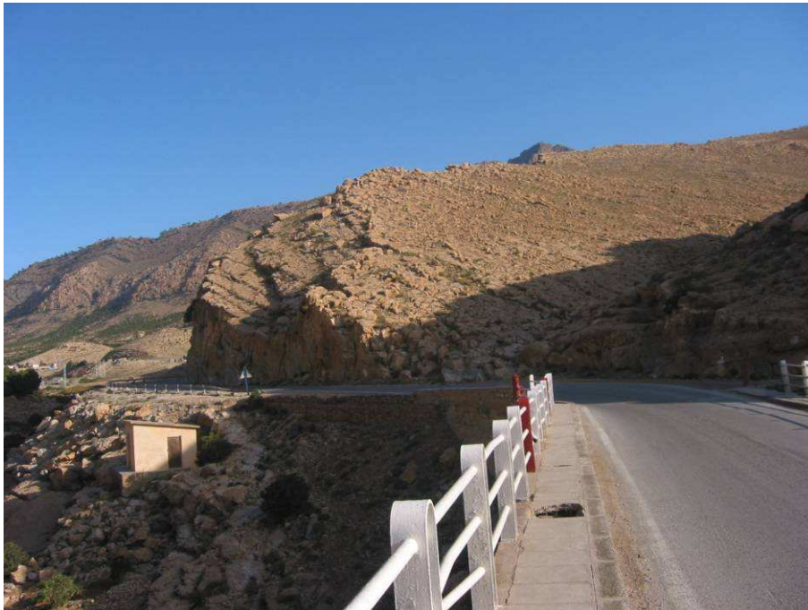
Photo N°5 : Vue de la rive gauche à partir de l'aval.
