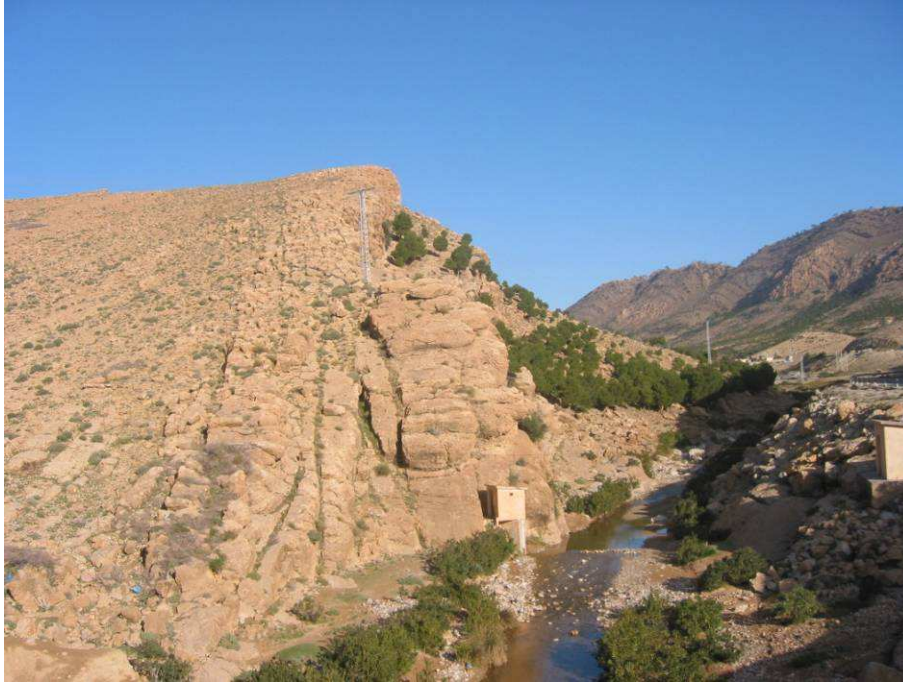
Photo N°4 : Vue de la rive droite à partir de l'aval.
