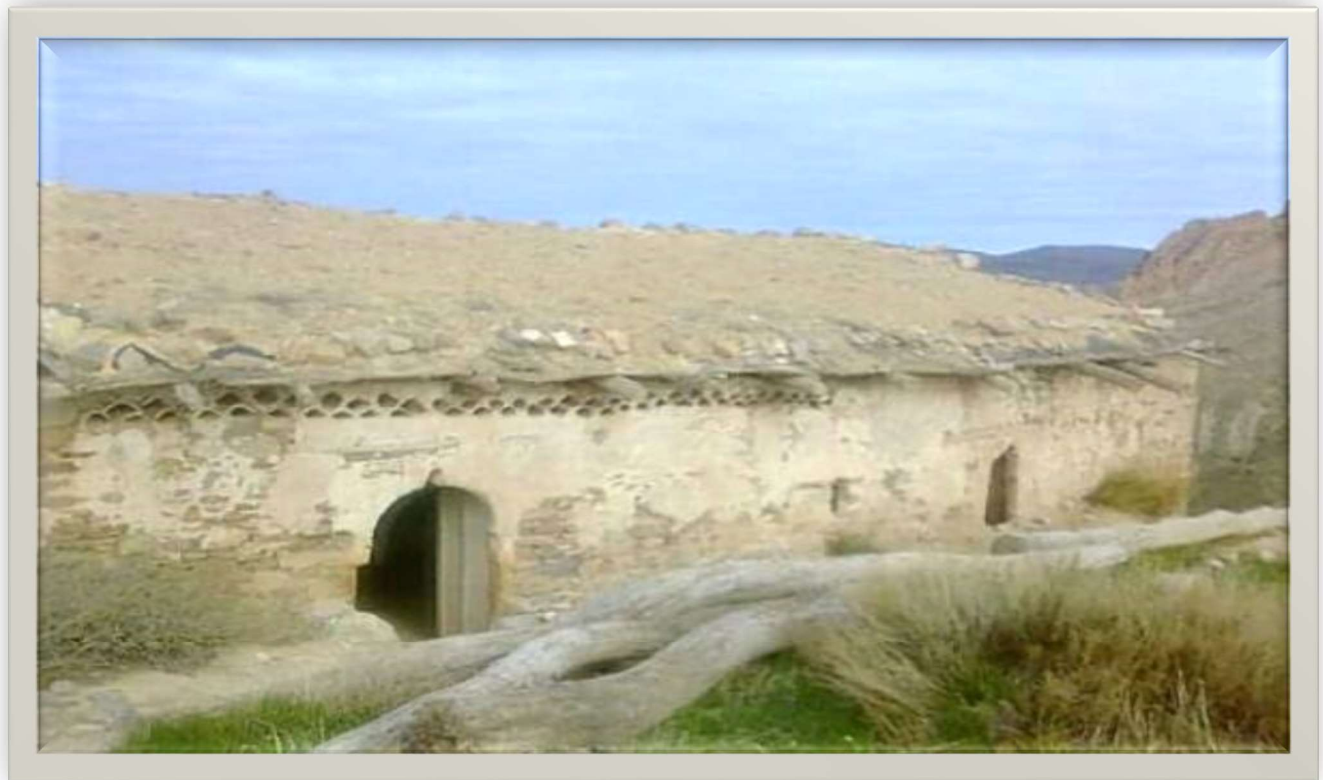
الصورة رقم 14 : تمثل الجانب الخارجي من المسجد الأعظم
