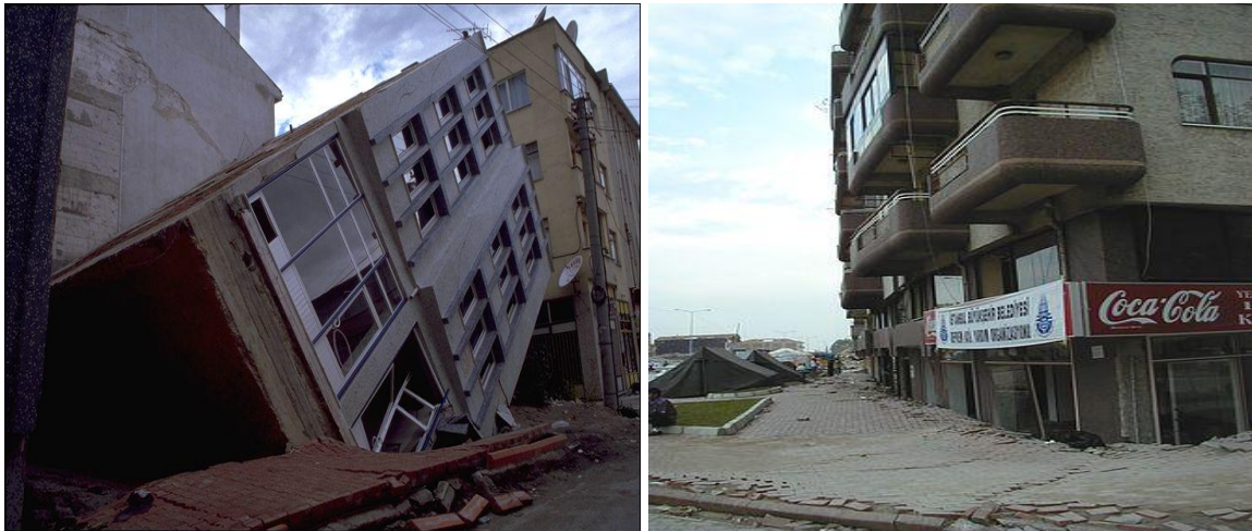
Figure II.14 : Liquéfaction des sols
