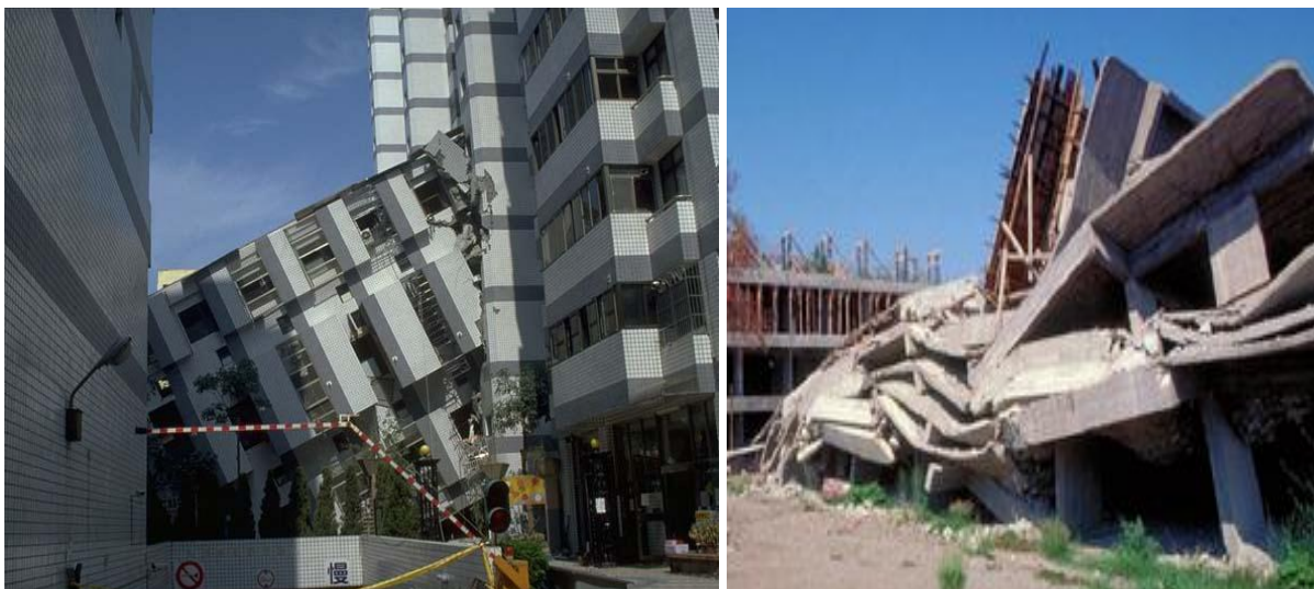
Figure II.6 : Effondrement d'un bâtiment sous forme d'une galette
