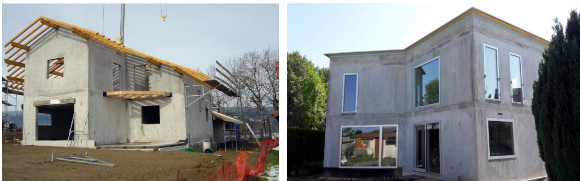
Figure II.3 : Construction d'une maison en voile béton armé
