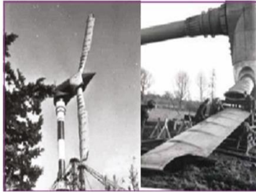
Figure I.5 : Eolienne de 100kw de Grand vent [17].
