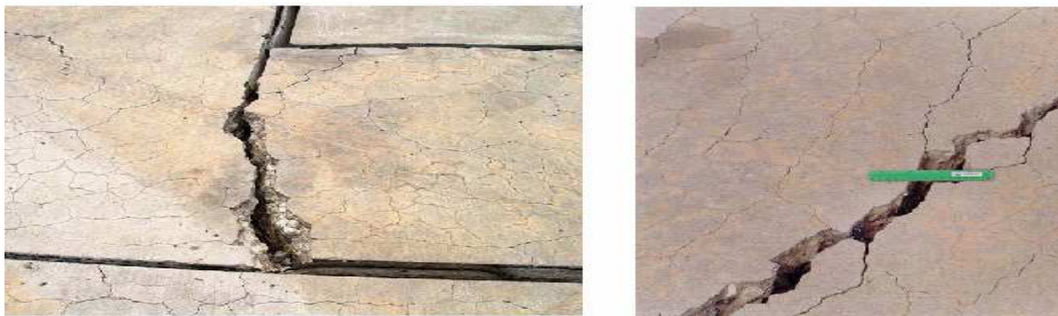
Fig.(1.19) :phénomène d'alcali réaction rencontré.
