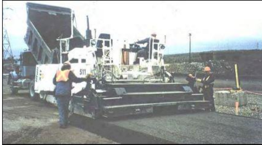
Figure 3 - finisseur à haut pouvoir de compactage. [3]
