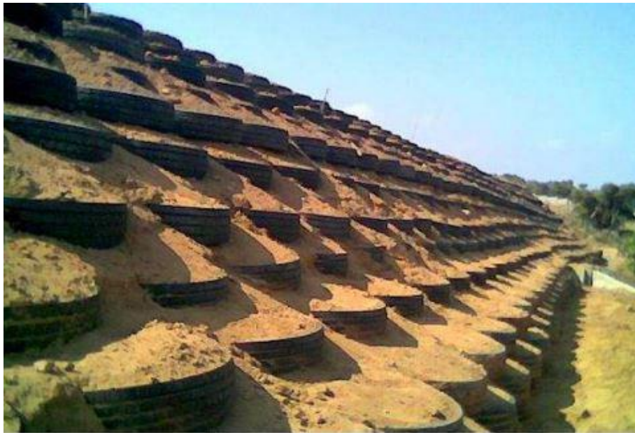
Figure 4 - chantier expérimentale Pneu sol à Bou-Smail. [16]
