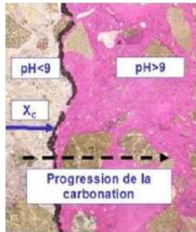
Figure III-19 Exemple de test à la phénolphtaléine {Thiery, 2005 #391}.
