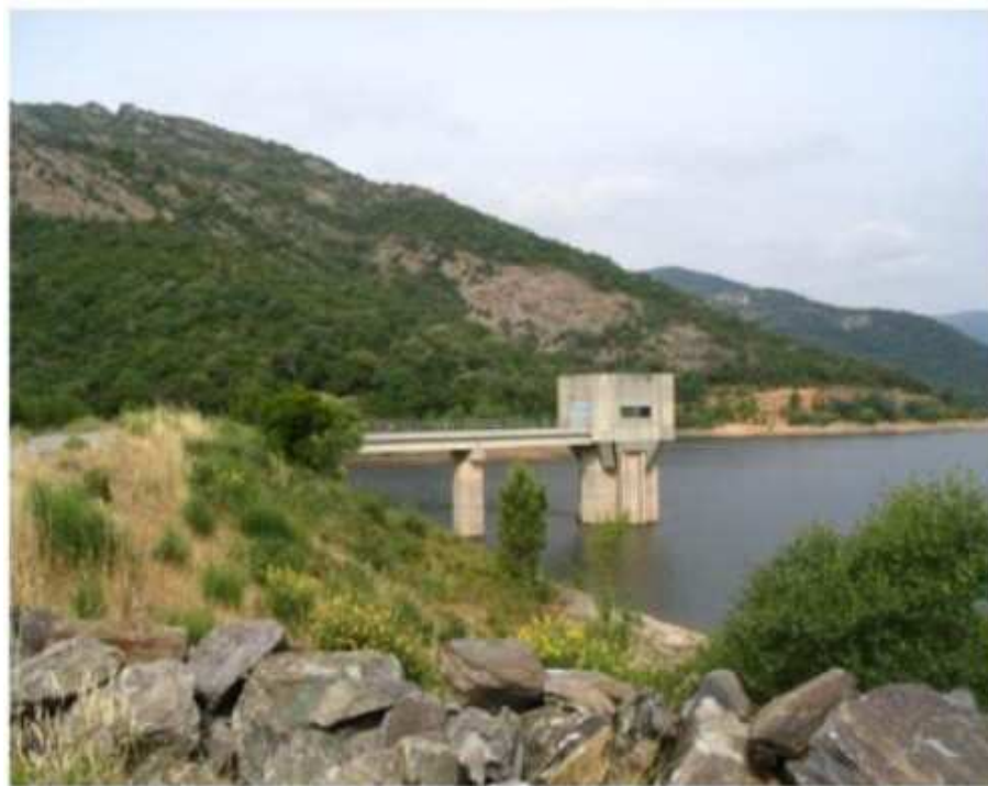
Figure I.16 : Tour de prise d'eau
