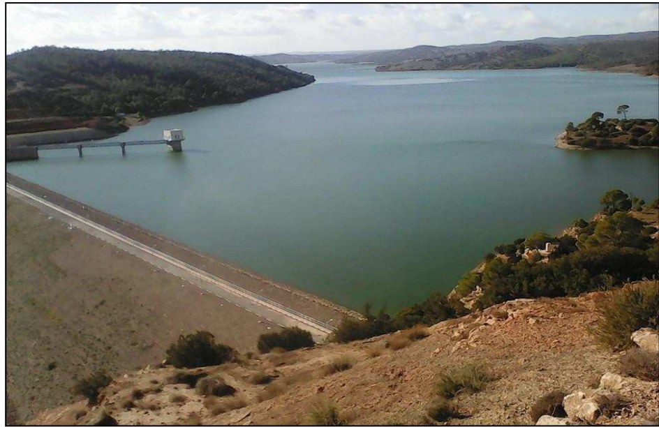
Figure II.5 : Vue du barrage Tilesdit.
