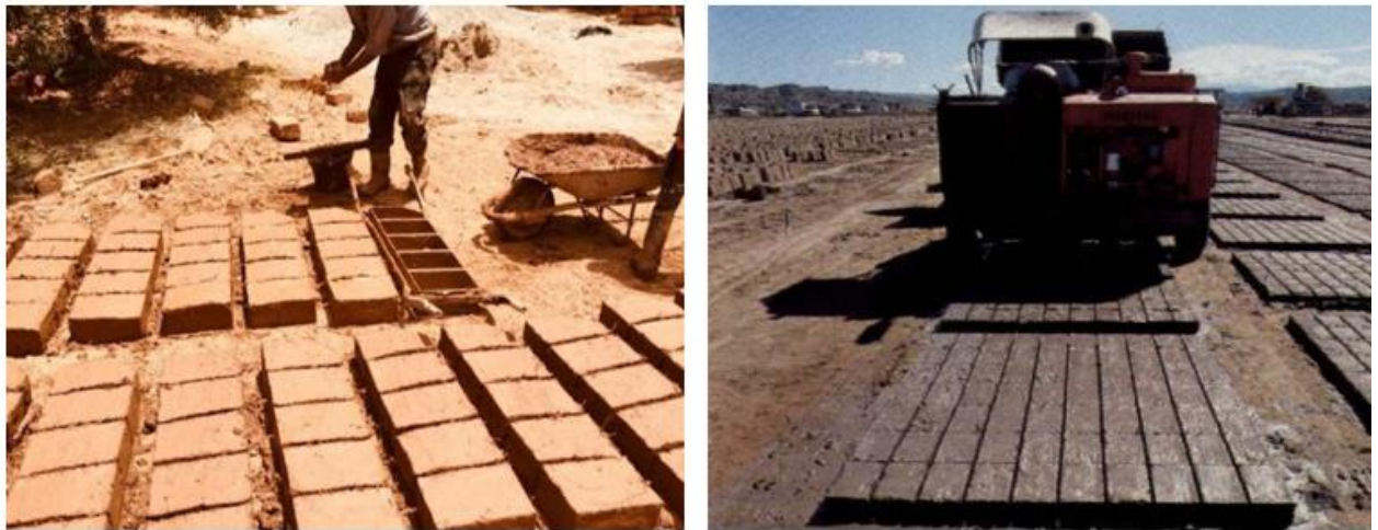
Fig III. 5. Les deux modes de fabrication d'adobe
